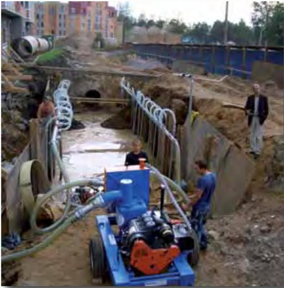
Stromnetzunabhängige Diesel-Pumpaggregate können überall dort eingesetzt werden, wo kein elektrischer Strom zur Verfügung steht. Sie können ebenso, wie die Elektro-Vakuumpumpaggregate (siehe Seite 4), für die unterschiedlichsten Wasserhaltungsmaßnahmen eingesetzt werden, wie z. B. die geschlossene Wasserhaltung mit Vakuumfiltern oder Vakuumtiefbrunnen, für offene Wasserhaltungen oder bei Drainage- und Flachbrunnen.
